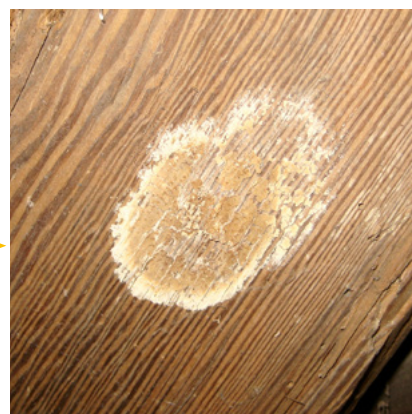
Figura 6. Corpo fruttifero secco di marciume provocato dal fungo Coniophora puteana su una trave (foto Mates II in Wikimedia Commons)
