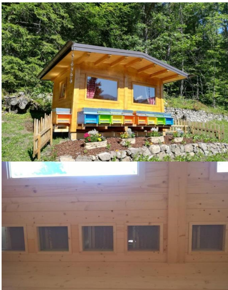
Apiario attrezzato per il respiro dell'aria dell'alveare. Dettaglio dell'interno con finestre dotate di reti che consentono l'ingresso dell'aria dell'alveare nell'abitacolo.
